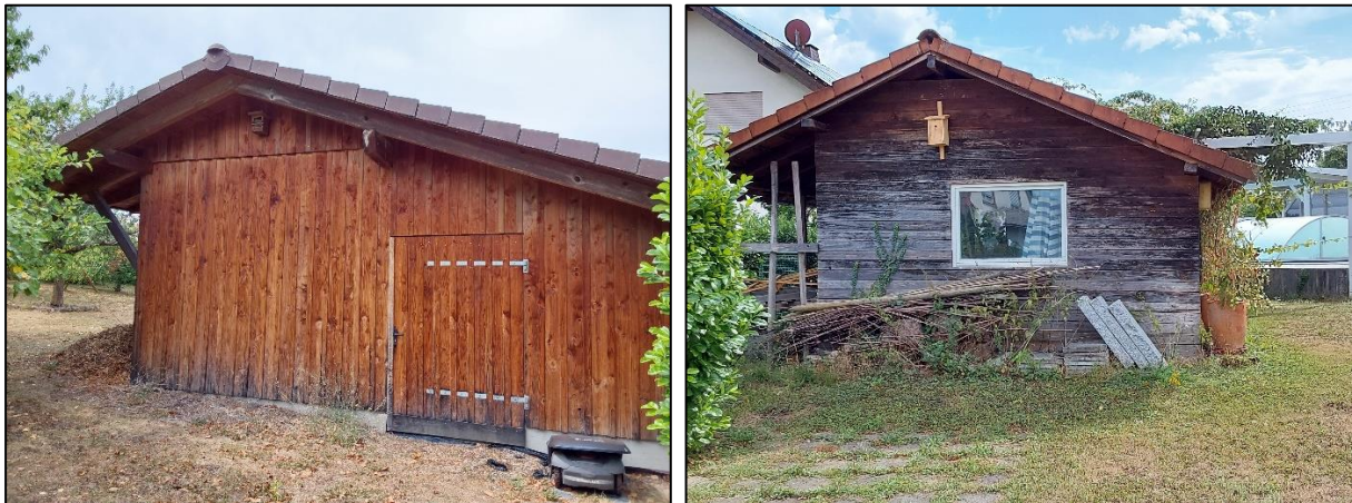
Abb. 2 + 3: Größerer Schuppen im nördlichen Bereich der Fläche (links) und kleinerer Schuppen an der östlichen Plangebietsgrenze (rechts).
